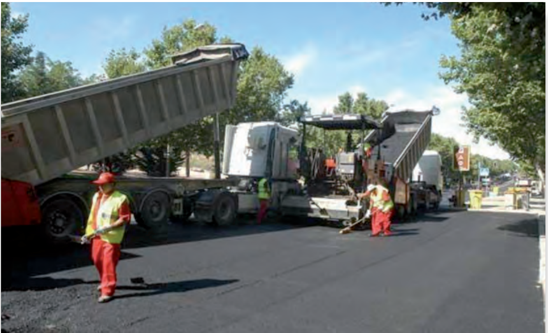
Asfalto. Operaciones de asfaltado de carretera
